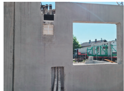
Setzen der Fertigwand inklusive aller Leitungen
