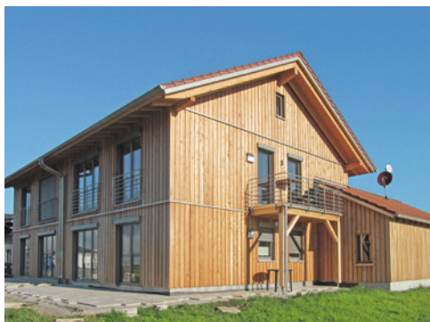
Doppelhaus in Holzbauweise
