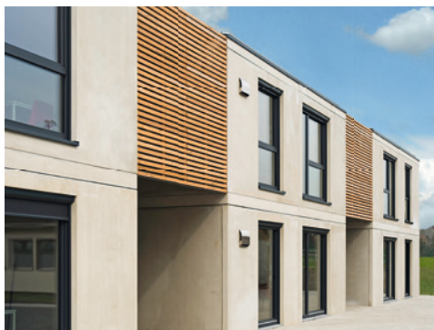
Modulbau-Sozialwohnungen in Schöppingen
