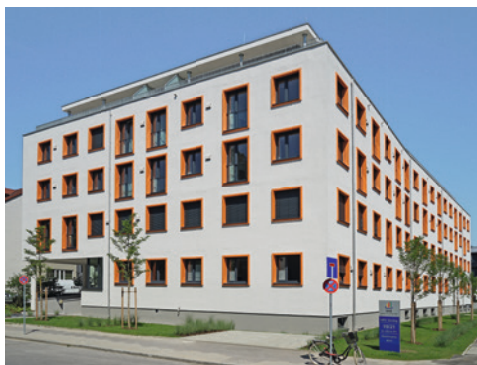
Förderzentrum München Giesing
