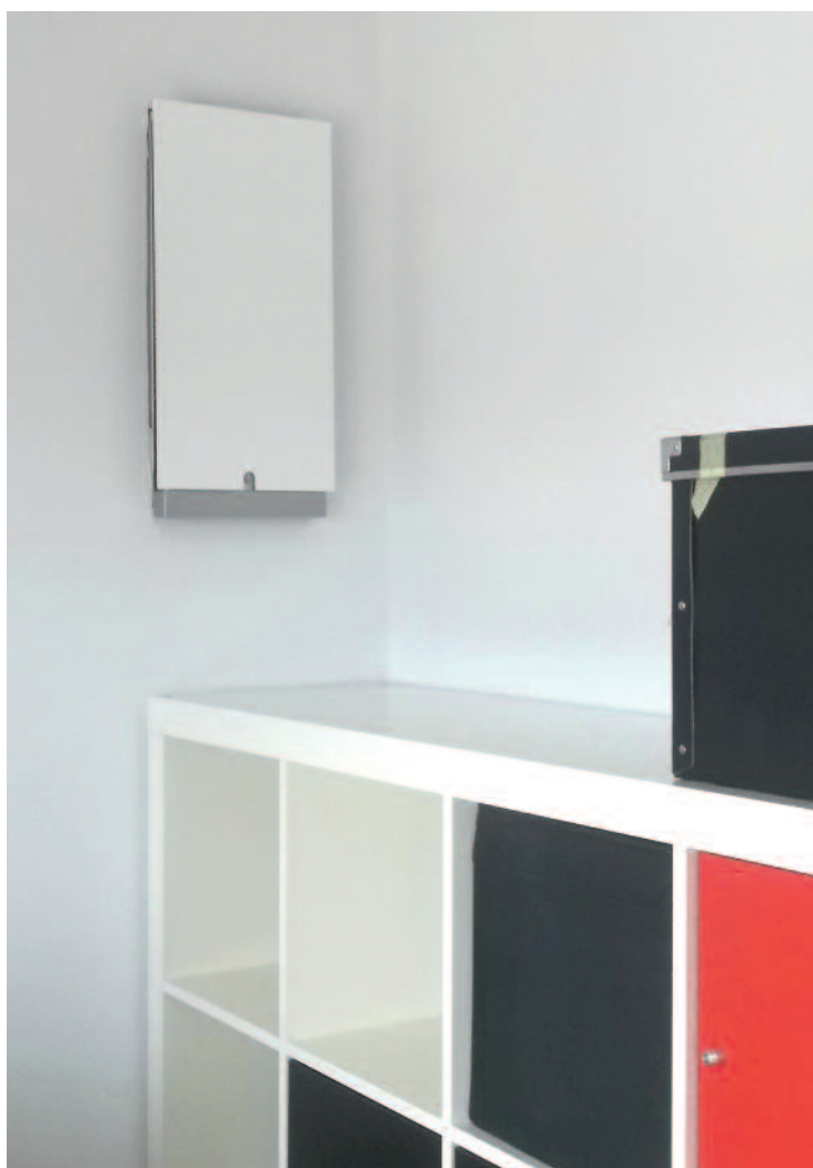
Die Frontplatte des Lüftungsgeräts freeAir 100 ist kaum größer als ein A3-Blatt und kann im Farbton der Wand gestrichen werden. (Bilder: 1-4: Dietmar Lust, LUST Energie + Technik)
