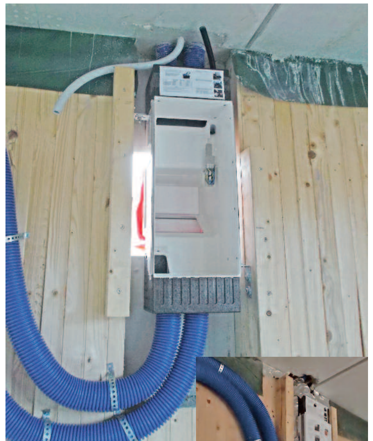
Bild 2: Einbausituation der Lüftung innen vor dem Einbringen der Steinwolle für den Brandschutz rund um das Rohbauset. Die Zuluftleitungen (unten abgehend) werden in der Installationsebene geführt. Die Abluft (oben abgehend) wird in der Rohdecke (Beton) geführt.
