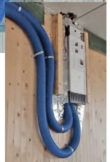
Bild 2: Einbausituation der Lüftung innen vor dem Einbringen der Steinwolle für den Brandschutz rund um das Rohbauset. Die Zuluftleitungen (unten abgehend) werden in der Installationsebene geführt. Die Abluft (oben abgehend) wird in der Rohdecke (Beton) geführt.
