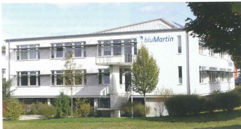
Das Betriebsgebäude wurde 2003 in Passivhausbauweise erstellt. Da die Lüftung nicht optimal arbeitete, ergab sich daraus ein umfangreiches Experimentierfeld.
